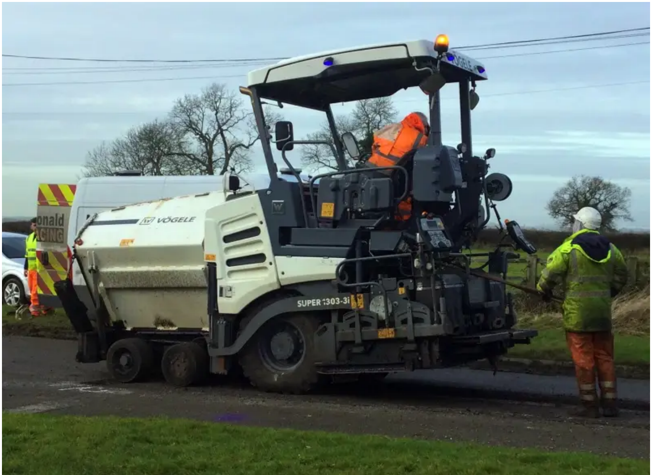
The Voegle Road Paver
